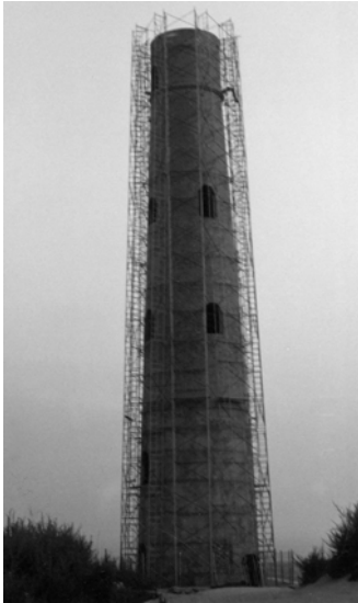
Torre de perdigones en construcción similar a la que ha anunciado Heredia
